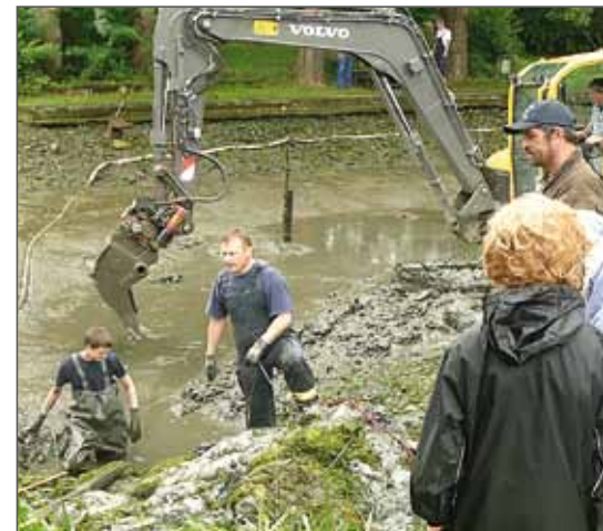
Eike Deutschländer und Godehard Wehr unterstützen den Bagger im Schlamm.
